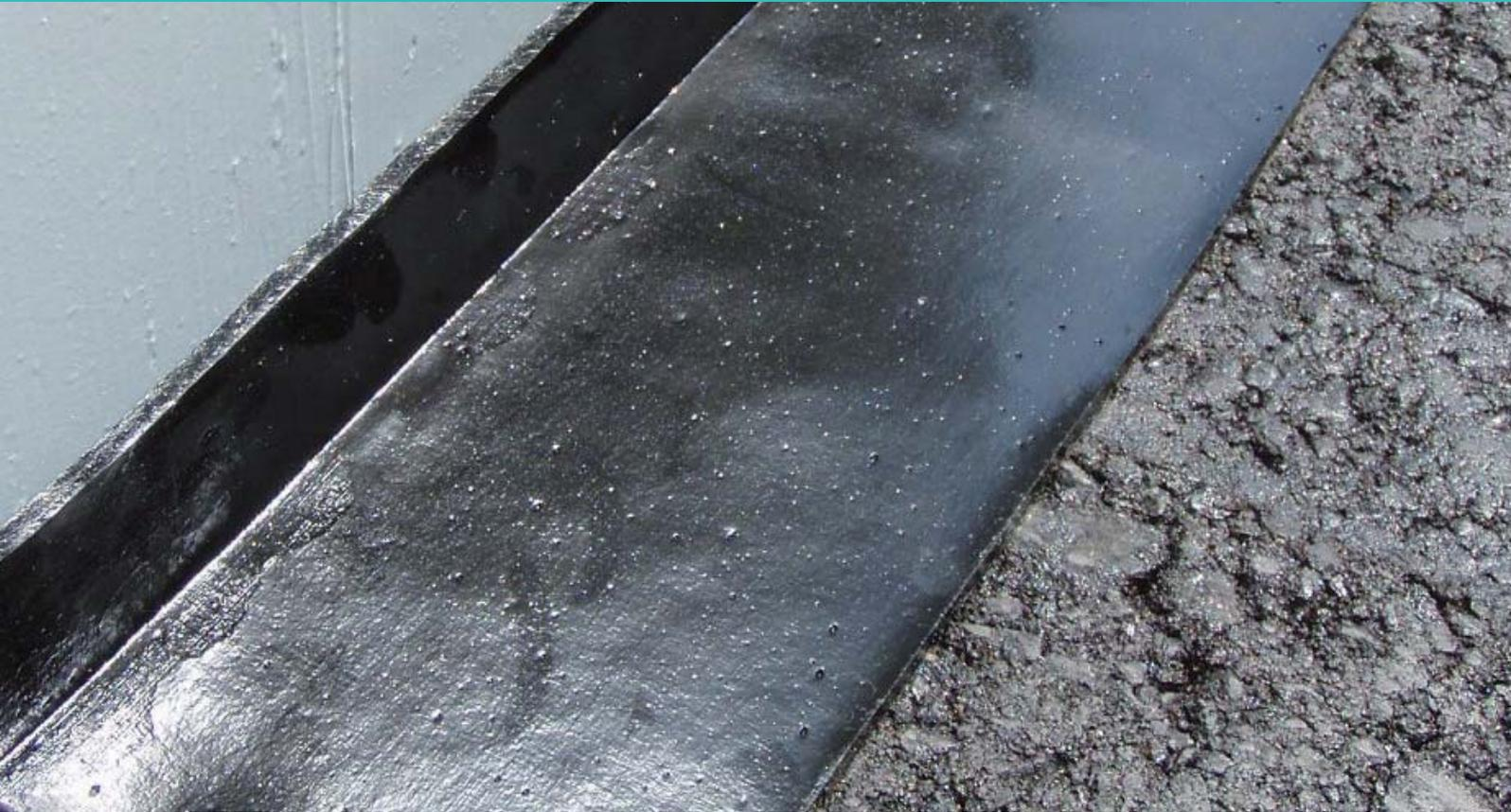
**概要** RC目地シールL字型は特殊アスファルトに熱可塑性エラストマー、ゴムなどをブレンドしたテープ状の成型目地材です。テープにくぼみを付けることにより、L字型にしやすいように成型してあります。橋梁端部などの水が溜まりやすい場所でも止水効果を発揮し、床版上面への水の浸入を抑制できます。
