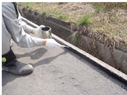
プライマー塗布
