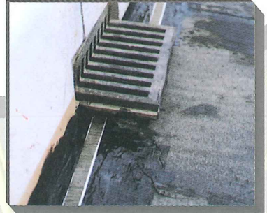
導水テープ排水桝接続
