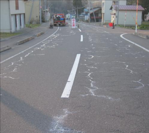
アスファルト舗装の加熱注入式クラックシール材
