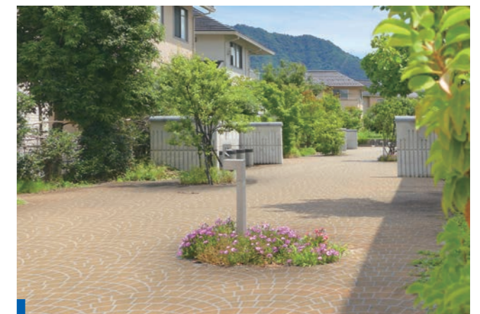
住宅地 スプレーステンシル工法
