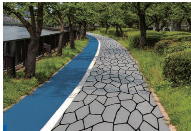
歩道 カラー工法 スプレーステンシル工法
