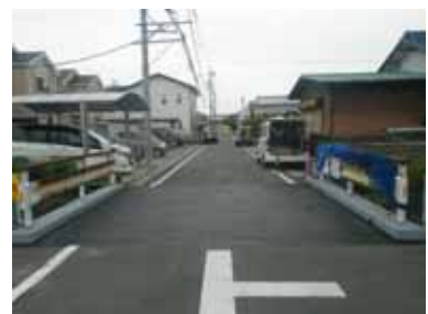
施工現場の例
