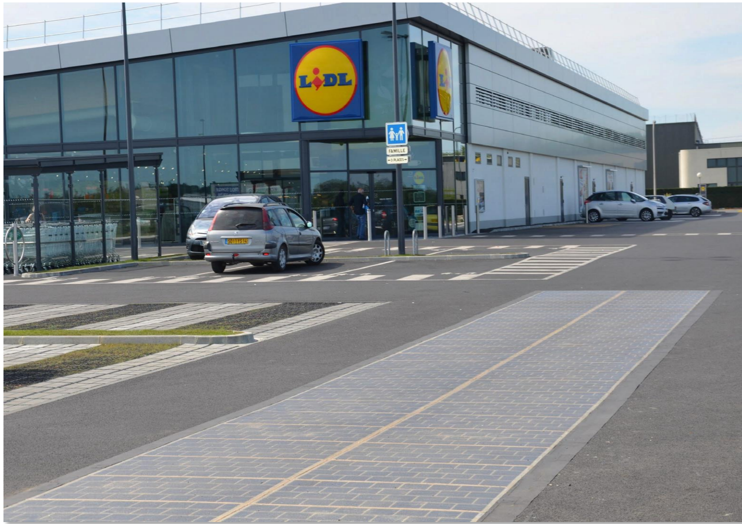
フランス Moulins Wattwayを48枚敷設して、商業施設で自家消費利用されています。 ©Colas-Joachim BERTRAND
