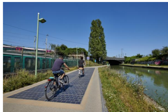
フランス Bobigny 54枚のWattwayと充電設備で道路照明を点灯しています。 © Chump-Manuel Lagos Cid
