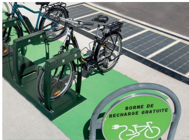
イギリス 企業の駐車場 Wattwayを216枚敷設して、隣接する施設の電源の一部として利用されています。 © PictureDesk Pictures55
