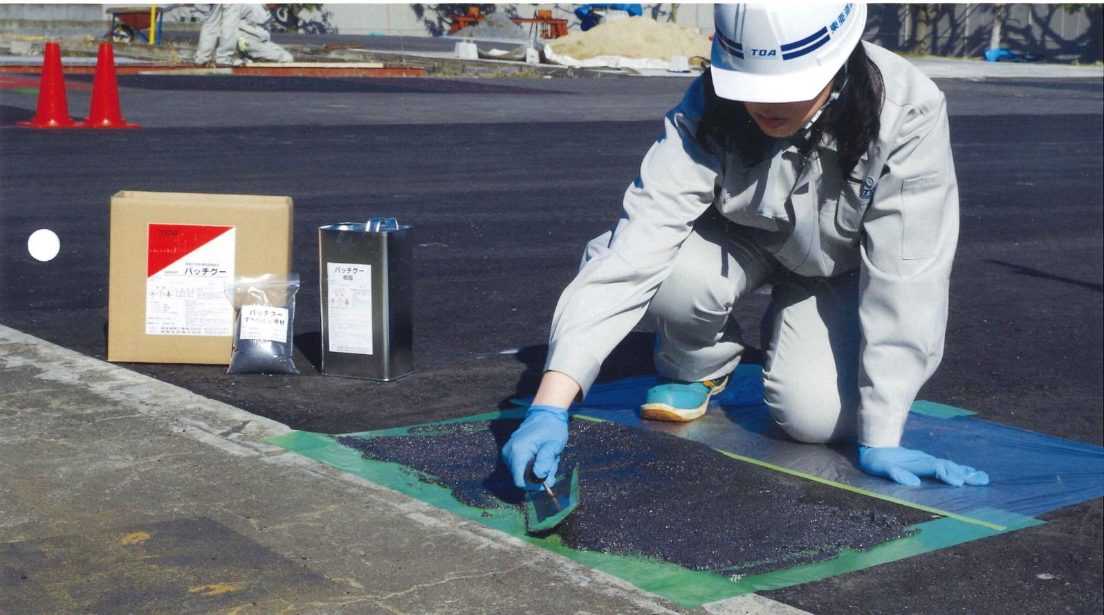
**概要** パッチグーは、橋梁ジョイント部やマンホールなどと舗装面に生じた段差の修正、そしてポットホールの穴埋めなど、路面に生じた様々な破損を補修できる特殊アクリル樹脂系路面補修材です。特殊な機材や工具を必要としません。誰でも簡単確実な施工を可能とし、施工後、短時間で交通開放できます。
