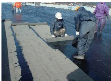
3.アスファルトコンパウンド塗布 およびタフシャット I 型貼付
