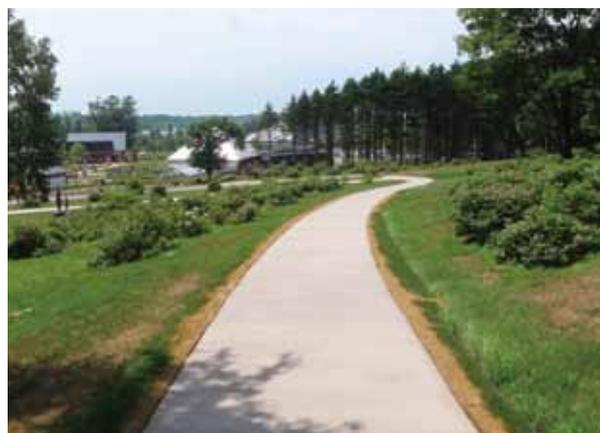
ネイチャーコートARは、天然骨材の持つ落ち着いたやわらかい風合いをそのまま表現する、環境にやさしい水性ポリエステルエマルジョン用いた土・砂風常温薄層舗装です。素材に天然骨材を使用することで、自然な色調と質感をもつ舗装が実現します。
