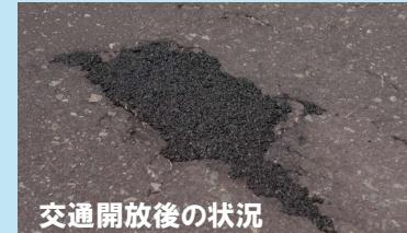
施工後、すぐに交通開放可能です。車両が施工箇所を通過することで転圧され、TOKE・パックがポットホールの隅々まで行きわたり硬化します。
