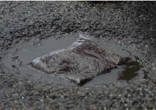
◆全天候型の常温アスファルト混合物なので、雨天時や路面に滯水していても施工可能です。
