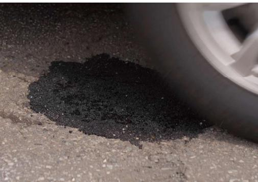
◆高速道路で施工後1週間経過しても剥がれなどせず、本補修までのつなぎとして高い耐久性を有しています。
