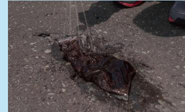
全体にまんべんなく散水してください。包装材がだんだんと溶けてきて、アスファルト混合物が露出してきます。
