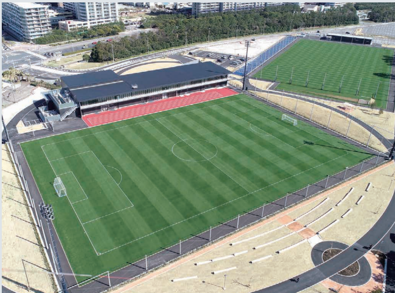
JFA 夢フィールド(当社実績/2019年竣工)
