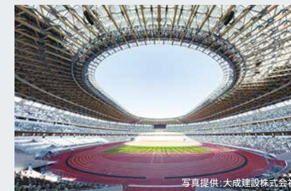
国立競技場(2019年/スタジアム地下舗装)
