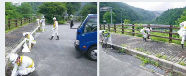
「ハートフルしまね」島根県公共土木施設愛護ボランティア
