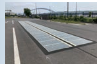
太陽光発電舗装システム「Wattway Pack」
