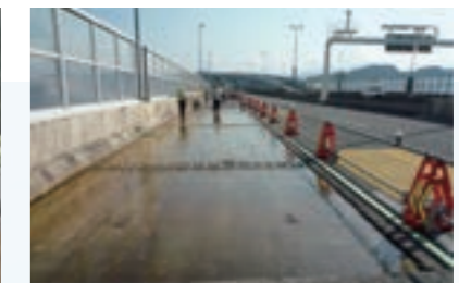
床版の長寿命化の実現に向けた樹脂防水一体型アスファルト舗装「タフシャットRA工法」
