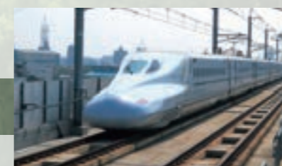
新幹線(軌道工事)
