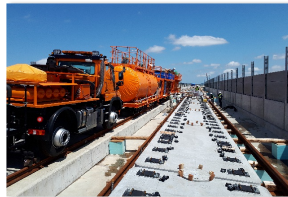
北陸新幹線 福井軌道敷設他工事
