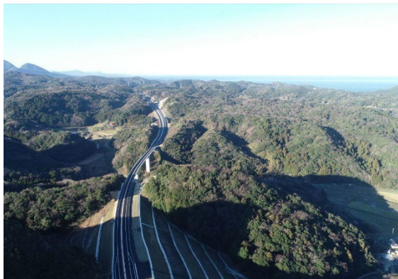
令和4年度静岡仁摩道路五十猛地区舗装工事 (国土交通省中国地方整備局)
