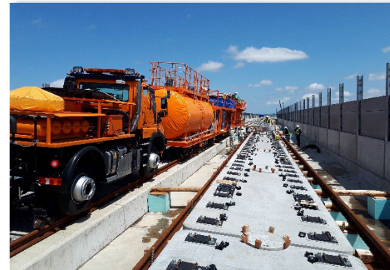
北陸新幹線 福井軌道敷設他工事
