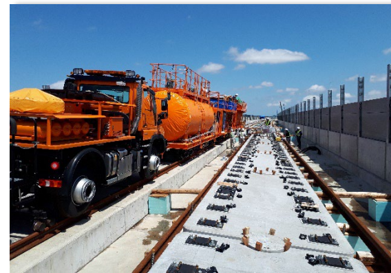
北陸新幹線 福井軌道敷設他工事
