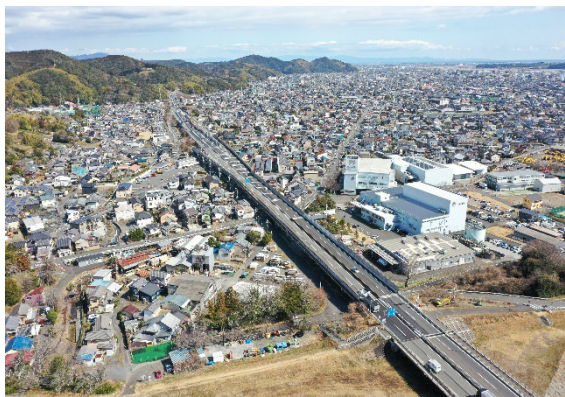
令和6年度 島田金谷BP舗装工事 (国土交通省中部地方整備局)
