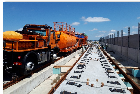
北陸新幹線 福井軌道敷設他工事
