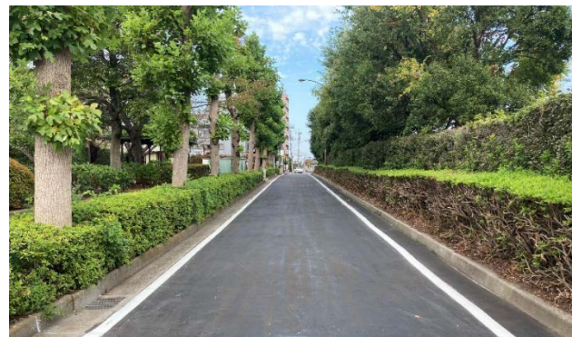
常温アスファルト舗装（東京都練馬区）
