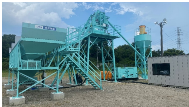
新設した常温アスファルト混合物製造プラント（茨城県つくば市）
