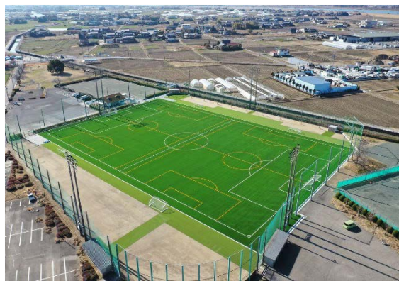
愛知県フットボールセンター愛西
