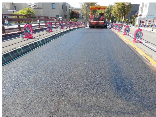
写真-2 基層舗設の状況
