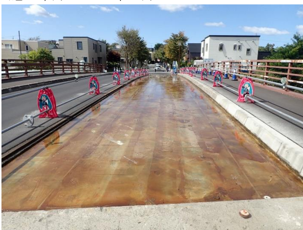
写真-1 樹脂防水材の塗布状況
