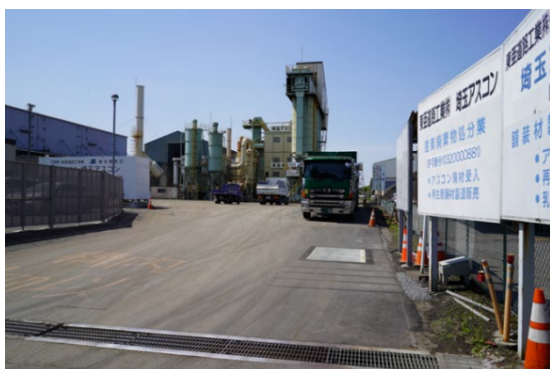
埼玉アスコン通路部の設置状況
