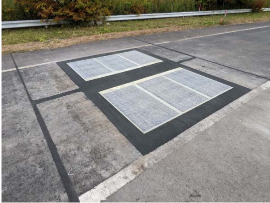
写真-1 舗装走行実験場での設置状況
