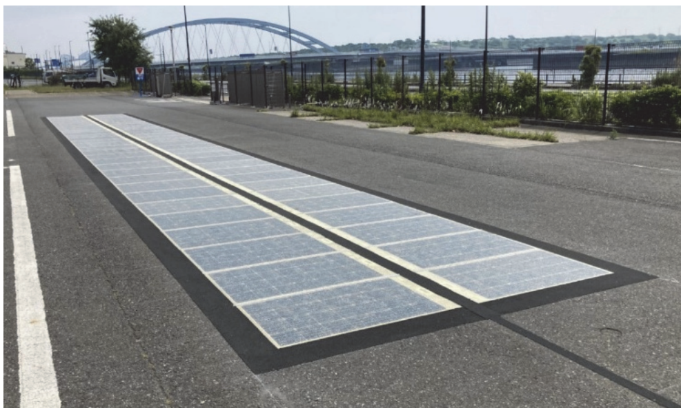
Wattway 設置状況
