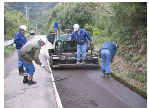
写真-3 常温アスファルト混合物の施工例
