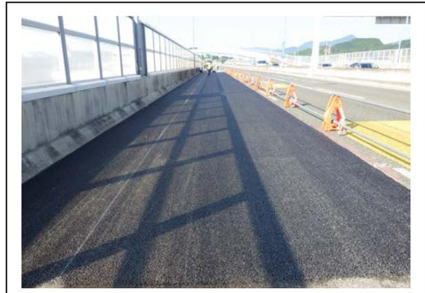
写真-2 舗設完了後の状況
