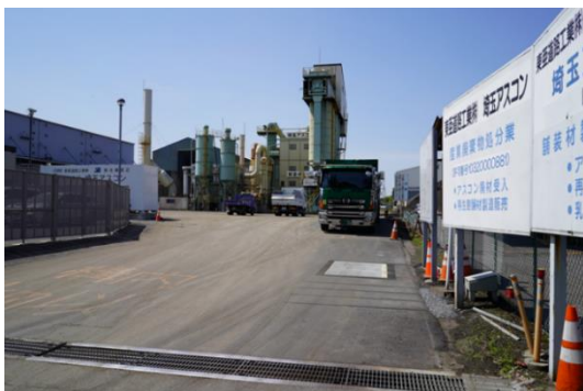
写真-5 埼玉アスコン通路部での設置状況
