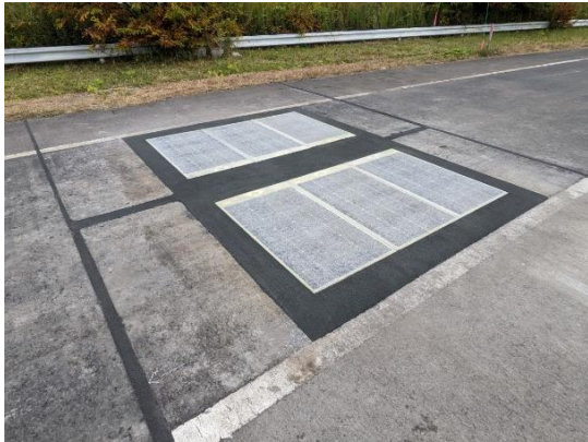
写真-1 舗装走行実験場での設置状況
