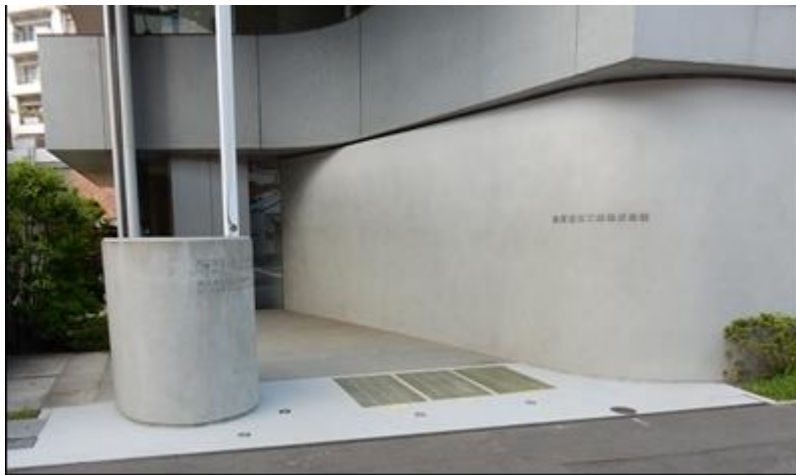
本社ビル エントランスの設置状況
